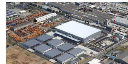
プロロジスパーク古河2と危険物倉庫
